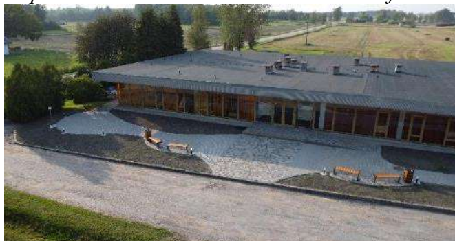
3.foto: Pēc pārbūves skats uz bibliotēkas pusi
